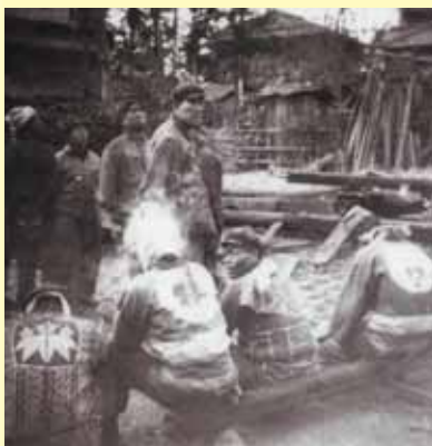
家の解体工事に集まる近隣の人たち
