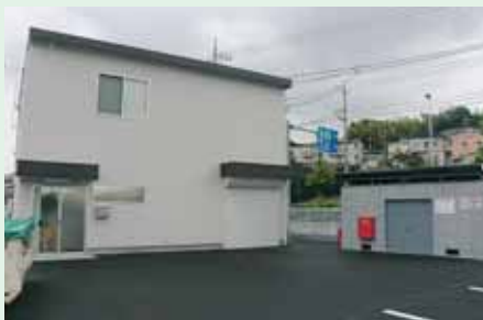
新築されたJAプロパンセンター川崎事務所
