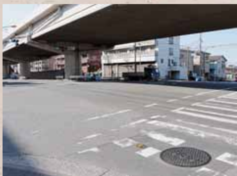
観音橋(川崎区)
