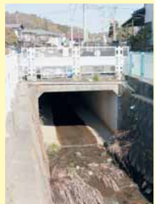
早野川の暗渠部分の出口
