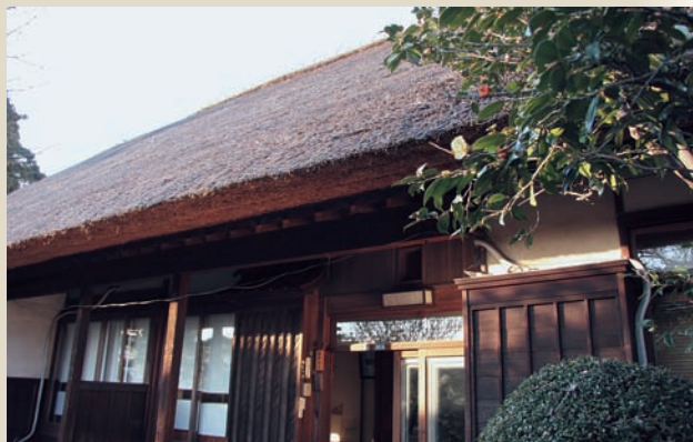
茅葺き屋根を保つ現在の白井家
