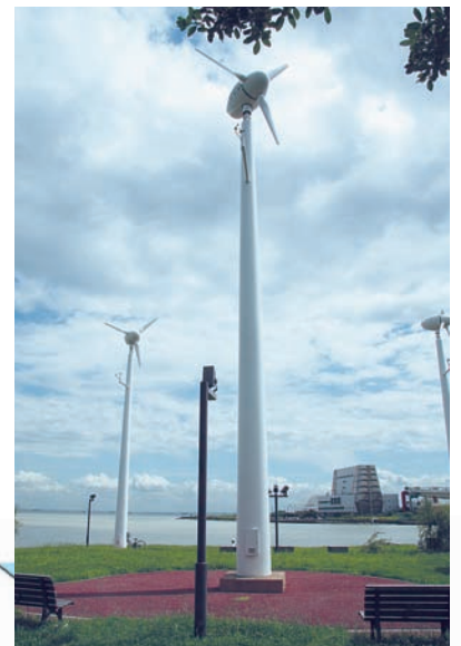
浮島町公園 浮島町公園には3基の風力発電装置があります。1基辺りの出力は2キロワット。公園内の外灯などの電力を賄っています
