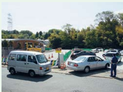
拡張工事中の店舗西側に臨時的な駐車場を設置
