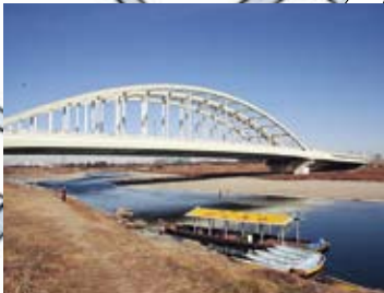
片側2車線、全長350メートルの多摩水道橋
