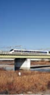
平成20年に複々急線多摩川橋梁
