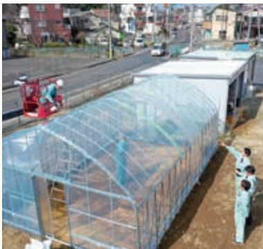
光触媒を塗布している様子
