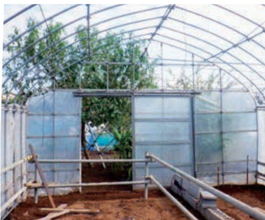
ビニールが剥がれたハウス
